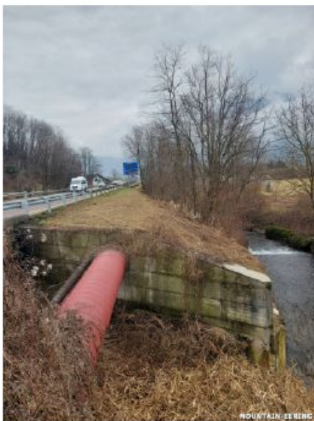
(c) S.S.47 e Fiume Brenta in prossimità dell'uscita del tunnel di progetto delle Alternative 3/4 - vista verso sud
