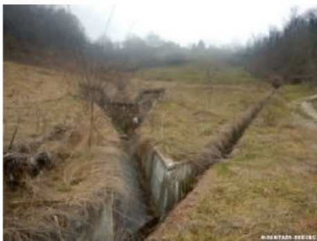
(a) Rio Fognature di Tenna in prossimità dell'uscita del tunnel di progetto dell'Alternativa 1 - vista verso est
