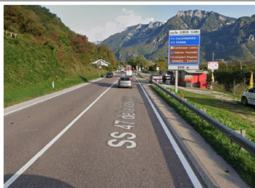
Foto 11 – Versate di uscita della galleria lato Levico Terme
