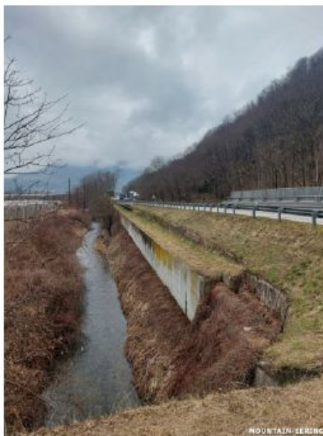
(d) S.S.47 e Fiume Brenta in prossimità dell'uscita del tunnel di progetto delle Alternative 3/4 - vista verso nord
