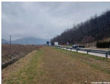
(b) S.S.47 e Fiume Brenta in prossimità dell'uscita del tunnel di progetto dell'Alternativa 2 - vista verso nord
